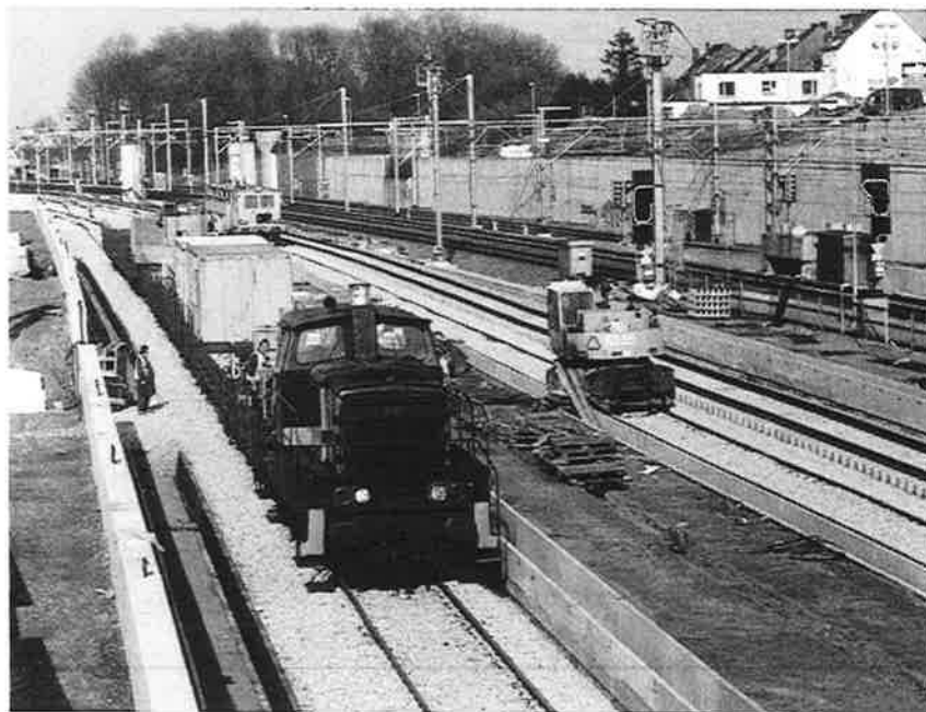
Les voies 1 à 3 de la nouvelle gare de Halle en cours de construction, mars 1999 Photo guy Bridoux
